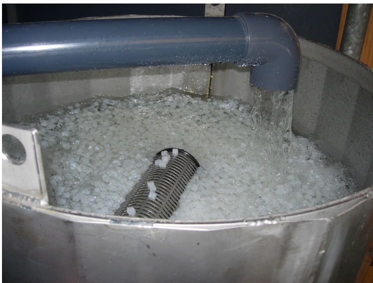
Runder und hoher Biofilter an einer Forschungsanlage der Universität Bern - Schweiz
